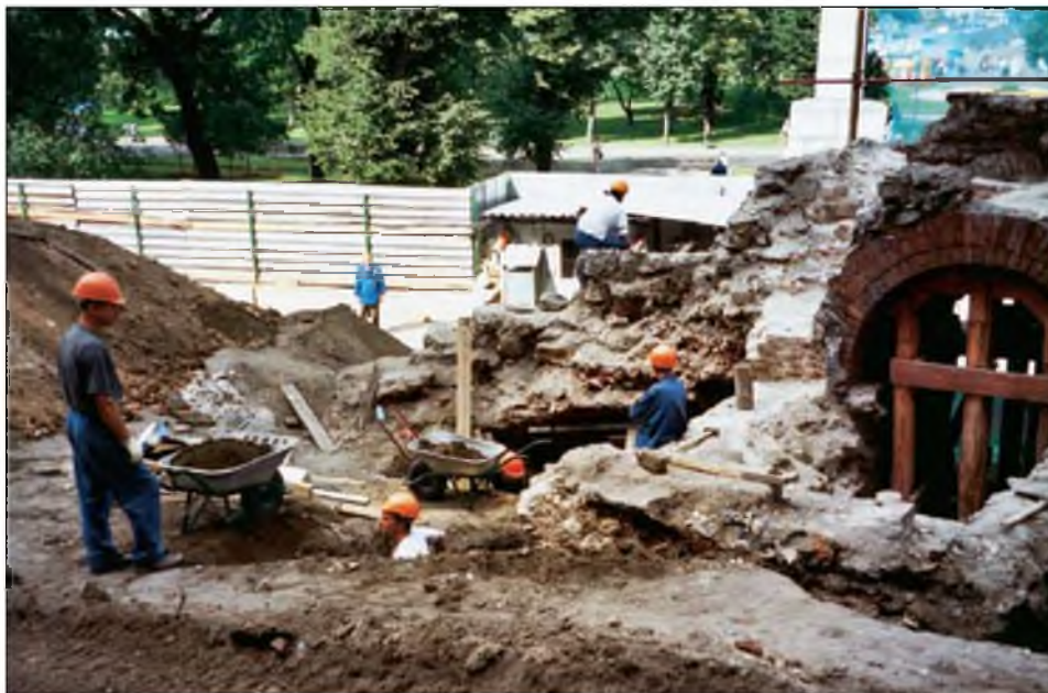
6. Земляные работы в южной части Грота в 2004 г. Фотография
