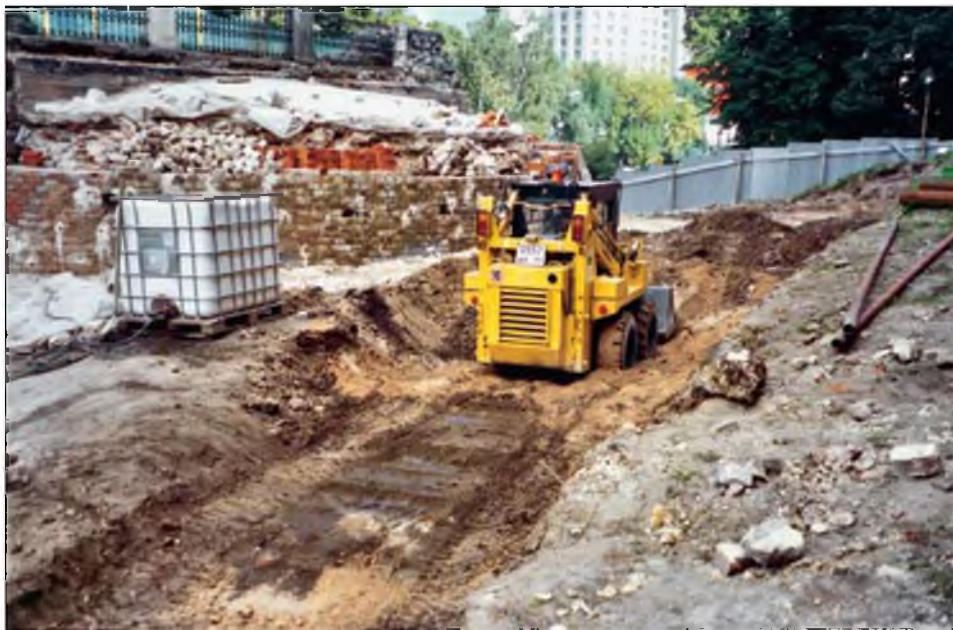
5. Начало земляных работ на участке за Гротом в 2004 г. Фотография
