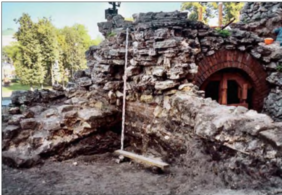
13. Начало земляных работ в западной части пространства за Гротом в 2004 г. Фотография
